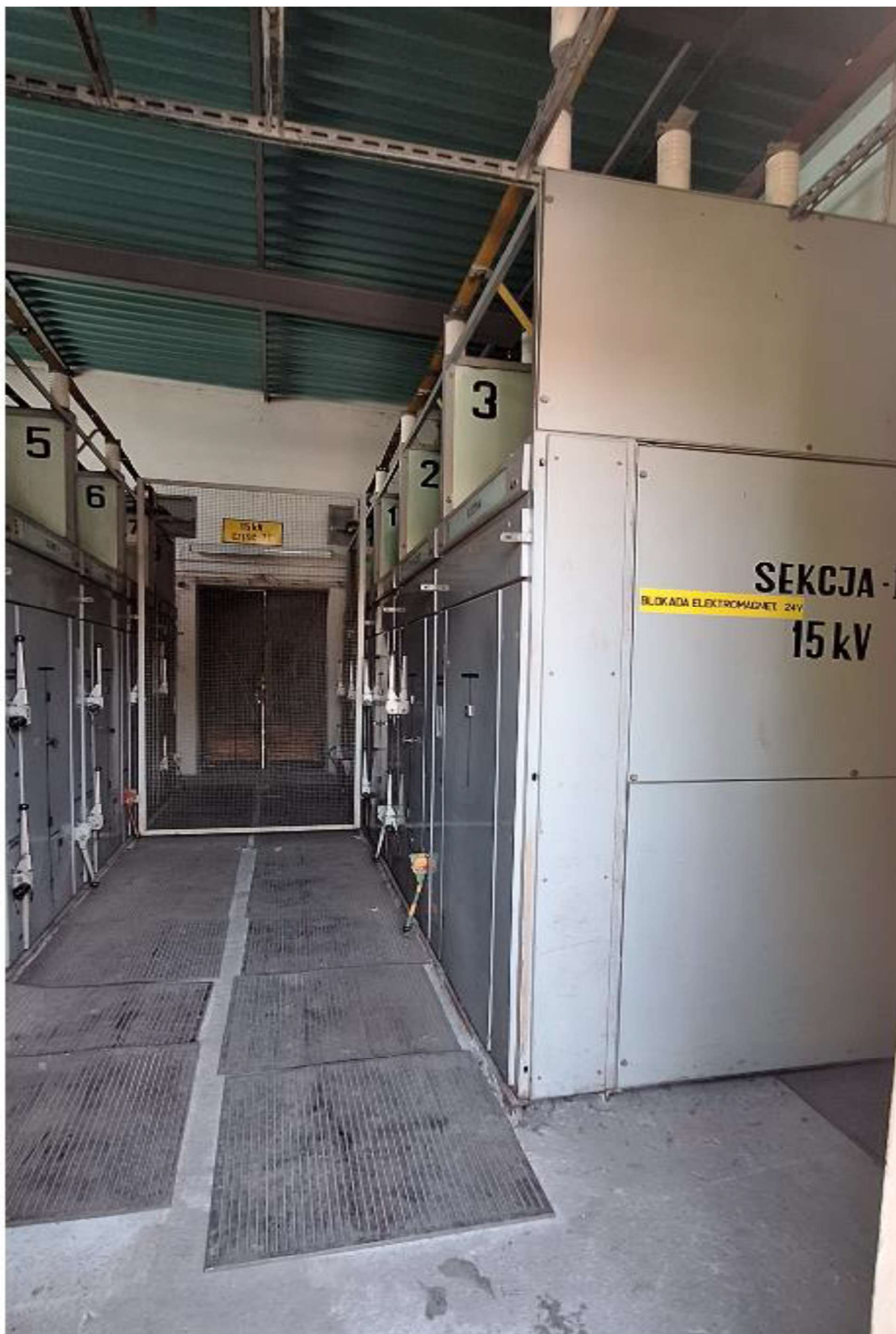
f) Widok rozdzielni BBZ40369 Żywiec Oczyszczalnia Sekcja I – przedział przedni
